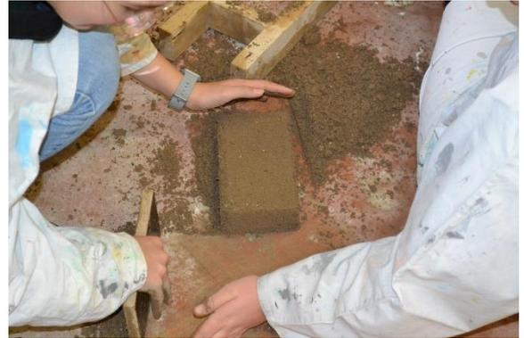
Construction de briques d'adobe « BTC » Brique de terre comprimée puis avec un simple moule en bois
